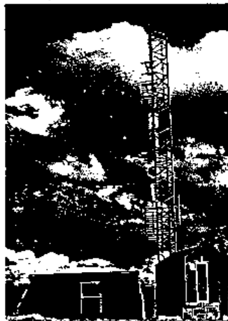
Den nybyggda slavstationen upp på Keitjurufjället länkar tevebilderna till de få familjerna i Övre Karesuando.
