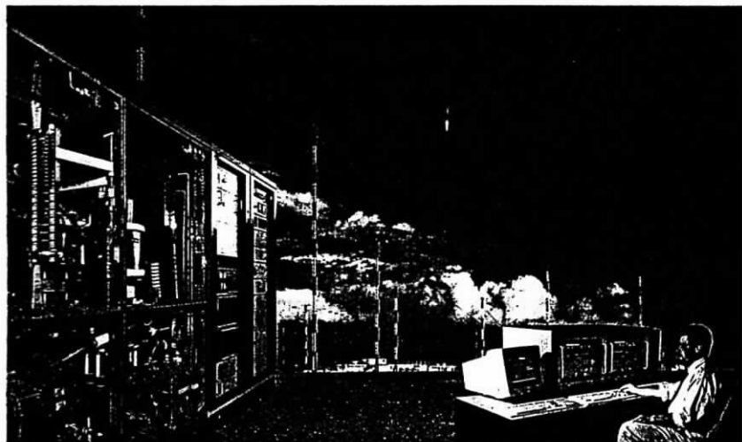
Sändare och huvudmanöverbord i en rundradlostation
